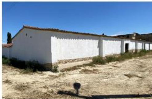
Φ.5: Βορειοδυτική πίσω όψη εξεταζόμενου κτηρίου Β'.
