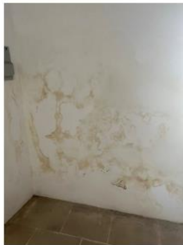
Φ.3, Φ.4: Εκτεταμένα προβλήματα ανιούσας υγρασίας με αποτέλεσμα το φούσκωμα και τοπική αποκόλληση του επιχρίσματος εσωτερικά του κτηρίου.
