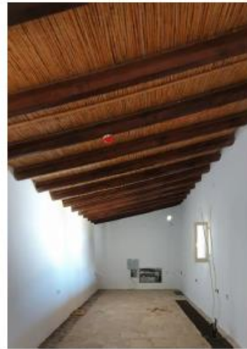
Φ.3, Φ.4: Εσωτερική άποψη της οροφής στη δυτική (Φωτ. αριστερά) και ανατολική (Φωτ. δεξιά) πτέρυγα που επανακατασκευάστηκε κατά την διάρκεια εργασιών αποκατάστασης το 2008 με ξύλινα βολίτζια και καλαμωτή.
