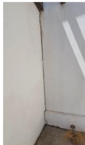
Φ.6, Φ.7: Εντονες κατακόρυφες ρωγμές που σχίζουν την τοιχοποιία σε όλο της το πάχος, ενώ ξεκινούν από τη στέψη οροφής και καταλήγουν στα θεμέλια. Οι εν λόγω ρωγμές παρατηρούνται στις γωνιές και στα σημεία ενώσεων με τους εγκάρσιους τοίχους αποτέλεσμα απουσίας περιμετρικού διαζώματος και ανεπαρκούς σύνδεσης μεταξύ εγκάρσιων τοίχων. Στη Φ.7 η ρωγμή φαίνεται να προκαλεί στροφική απόκλιση από την κατακόρυφο.
