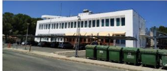
Φ.1: Πρόσωση του κτηρίου
