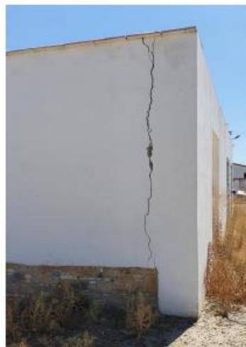
Φ.4, Φ.5: Μεγάλου εύρους διαμπερή κατακόρυφη εκτός επιπέδου καμπτική ρωγμή που διαπερνά την τοιχοποιία σε βάθος, ενώ ξεκινά από τη στέψη οροφής και καταλήγει στα θεμέλια. Στη Φ.4 φαίνεται η εν λόγω ρωγμή εξωτερικά, ενώ στη Φ.5 υποδείχεται η ίδια ρωγμή από την εσωτερική πλευρά του κτηρίου.
