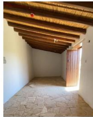
Φ.3, Φ.4: Εσωτερική άποψη της οροφής στη δυτική (Φωτ. αριστερά) και ανατολική (Φωτ. δεξιά) πτέρυγα που επανακατασκευάστηκε κατά την διάρκεια εργασιών αποκατάστασης το 2008 με ξύλινα βολίτζια και καλαμωτή.
