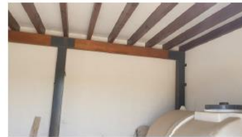
Φ.3: Άποψη εσωτερικού μεταλλικού σκελετού τμήματος του κτηρίου, όπου εδράζονται οι ξύλινες μορίνες της οροφής.
