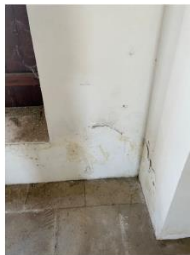
Φ.5, Φ.6: Εκτεταμένα προβλήματα ανιούσας υγρασίας με αποτέλεσμα το φούσκωμα, αποφλοίωση και την τοπική αποκόλληση του επιχρίσματος εσωτερικά του κτηρίου. Στη φωτογραφία δεξιά, ο τοίχος κάτω από τη σκάλα εφάπτεται της εξωτερικής σκάλας από φυσικό λίθο (βλέπε επόμενη Φ.7) η οποία εξωτερική σκάλα από πέτρα, φαίνεται να εγκλωβίζει την υγρασία η οποία εκτονώνεται στον τοίχο.
