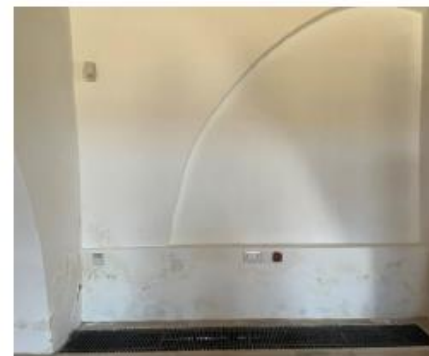
Φ.3, Φ.4: Εκτεταμένα προβλήματα ανιούσας υγρασίας με αποτέλεσμα το φούσκωμα και τοπική αποκόλληση του επιχρίσματος εσωτερικά του κτηρίου.
