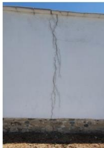
Φ.6, Φ.7: Εντονες κατακόρυφες ρωγμές που σχίζουν την τοιχοποιία σε όλο της το πάχος, ενώ ξεκινούν από τη στέψη οροφής και καταλήγουν στα θεμέλια. Οι εν λόγω ρωγμές παρατηρούνται στις γωνιές και στα σημεία ενώσεων με τους εγκάρσιους τοίχους αποτέλεσμα απουσίας περιμετρικού διαζώματος και ανεπαρκούς σύνδεσης μεταξύ εγκάρσιων τοίχων. Στη Φ.7 η ρωγμή φαίνεται να προκαλεί στροφική απόκλιση από την κατακόρυφο.
