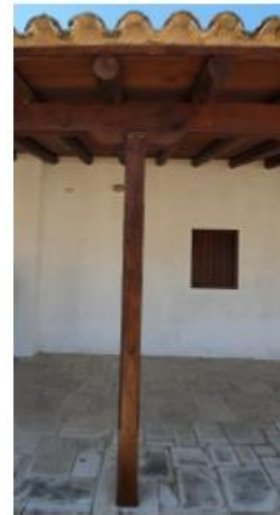
Φ.1, Φ.2: Νέο ξύλινο στέγαστρο το οποίο εφάπτεται κατά μήκος της πρόσοψης της δυτικής πτέρυγας του κτηρίου και λεπτομέρεια έδρασης ξύλινων δοκαριών επί ξύλινων κολωνών.
