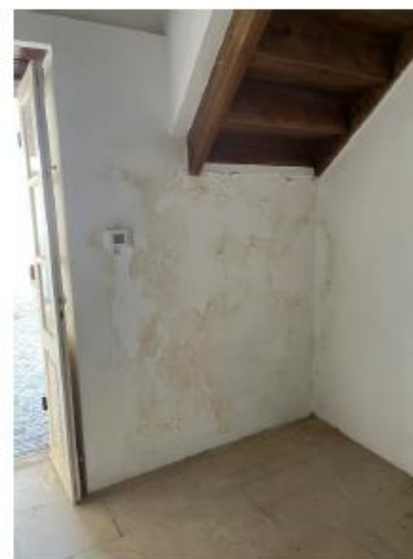
Φ.5, Φ.6: Εκτεταμένα προβλήματα ανιούσας υγρασίας με αποτέλεσμα το φούσκωμα, αποφλοίωση και την τοπική αποκόλληση του επιχρίσματος εσωτερικά του κτηρίου. Στη φωτογραφία δεξιά, ο τοίχος κάτω από τη σκάλα εφάπτεται της εξωτερικής σκάλας από φυσικό λίθο (βλέπε επόμενη Φ.7) η οποία εξωτερική σκάλα από πέτρα, φαίνεται να εγκλωβίζει την υγρασία η οποία εκτονώνεται στον τοίχο.
