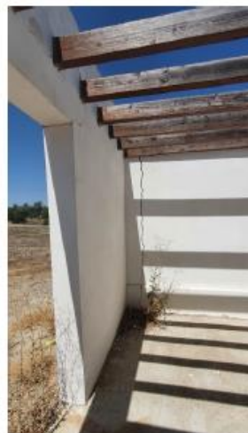
Φ.4, Φ.5: Μεγάλου εύρους διαμπερή κατακόρυφη εκτός επιπέδου καμπτική ρωγμή που διαπερνά την τοιχοποιία σε βάθος, ενώ ξεκινά από τη στέψη οροφής και καταλήγει στα θεμέλια. Στη Φ.4 φαίνεται η εν λόγω ρωγμή εξωτερικά, ενώ στη Φ.5 υποδείχεται η ίδια ρωγμή από την εσωτερική πλευρά του κτηρίου.
