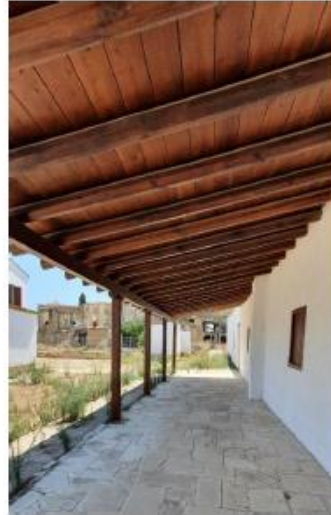
Φ.1, Φ.2: Νέο ξύλινο στέγαστρο το οποίο εφάπτεται κατά μήκος της πρόσοψης της δυτικής πτέρυγας του κτηρίου και λεπτομέρεια έδρασης ξύλινων δοκαριών επί ξύλινων κολωνών.
