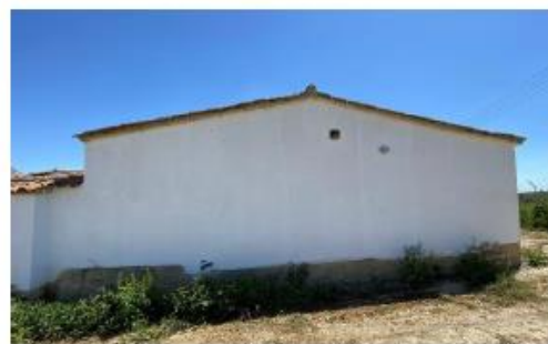
Φ.7: Δυτική όψη κτηρίου Β' η οποία έρχεται σε απευθείας επαφή με το εξωτερικό φυσικό έδαφος χωρίς να παρεμβάλλεται κάποια εδαφόπλακα.
