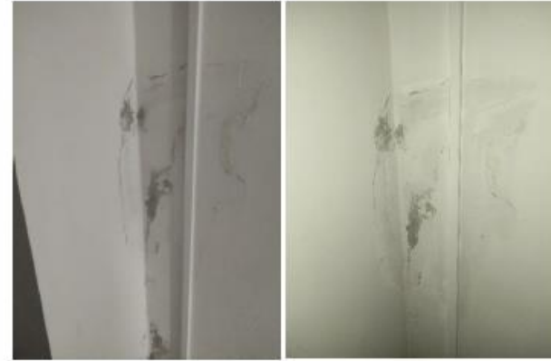
Φ.7: Τοπικά εκτεταμένα προβλήματα υγρασίας
