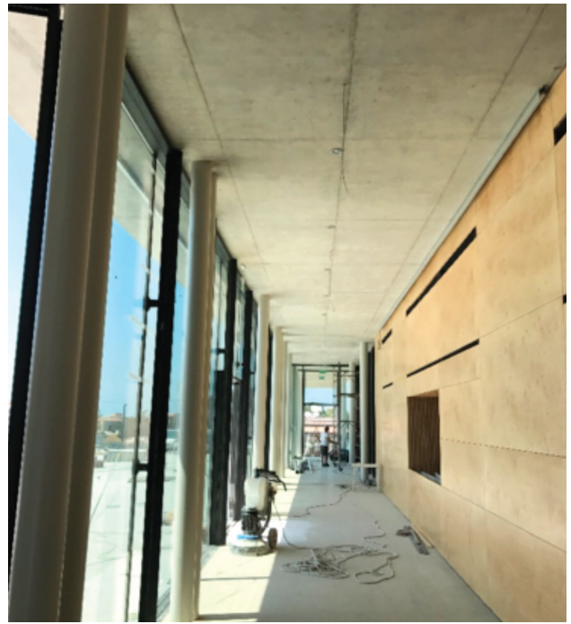
Είσοδος - Πλάκες εμφανούς σκυροδέματος επί σύμμικτων υποστρωμάτων
