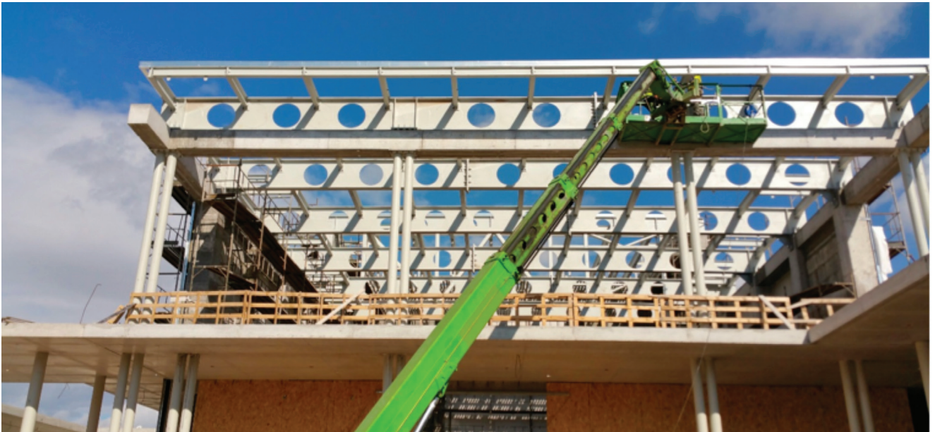
Τοποθέτηση μεταλλικών κυψελοειδών διατομών οροφής
