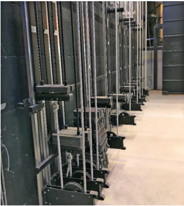
Κατασκευή συστήματος αντίβαρων σκηνικών και εξοπλισμού σκηνής
