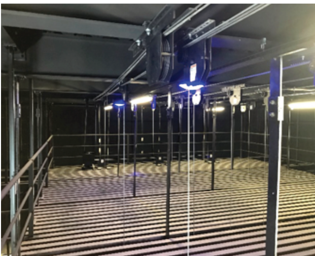
Δάπεδο συντήρησης σταγκωνιών αναρτώμενο από την οροφή
