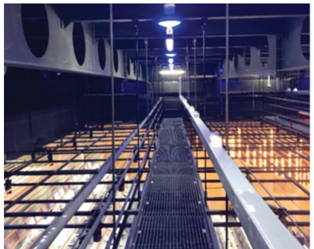
Μεταλλική κατασκευή εναέριας γέφυρας αναρτώμενη από την οροφή μέσω ελκυστήρων
